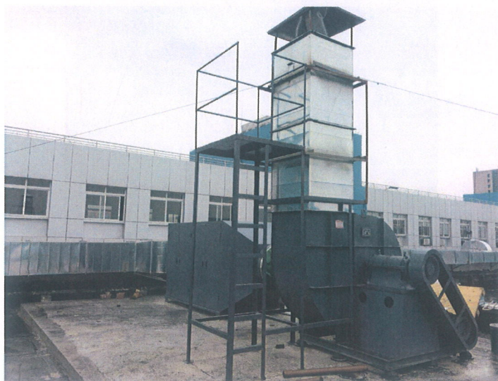
投料室烘干废气及注塑废气活性炭吸附装置
